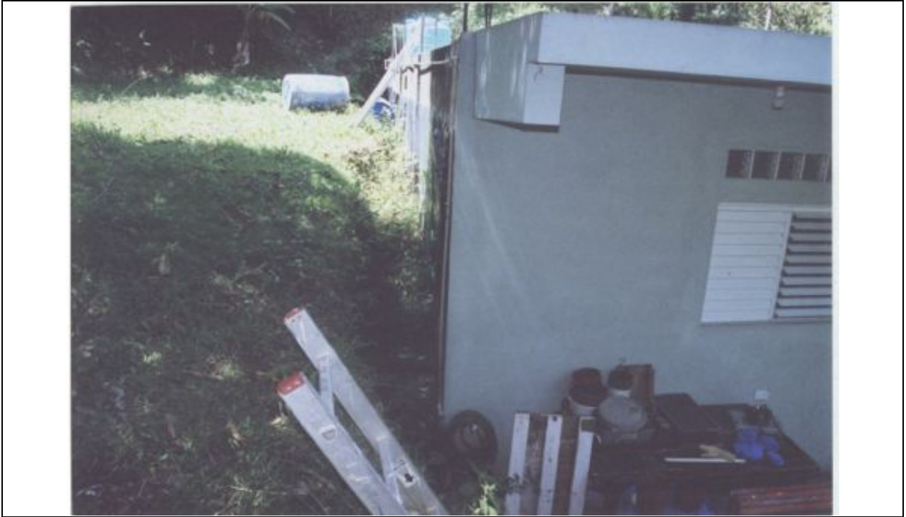
Foto 9 – Lado izquierdo y parte posterior de la residencia
