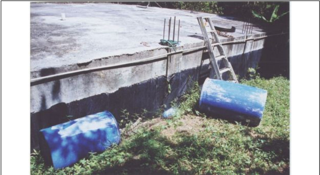
Foto 11 – Escalera de acceso al techo en la parte posterior de la residencia
