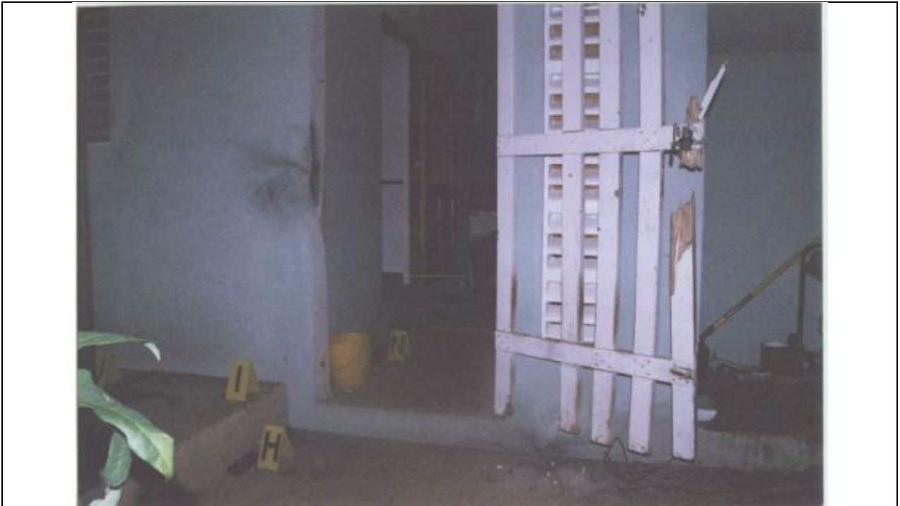
Foto 14 – Portón de la entrada lateral
