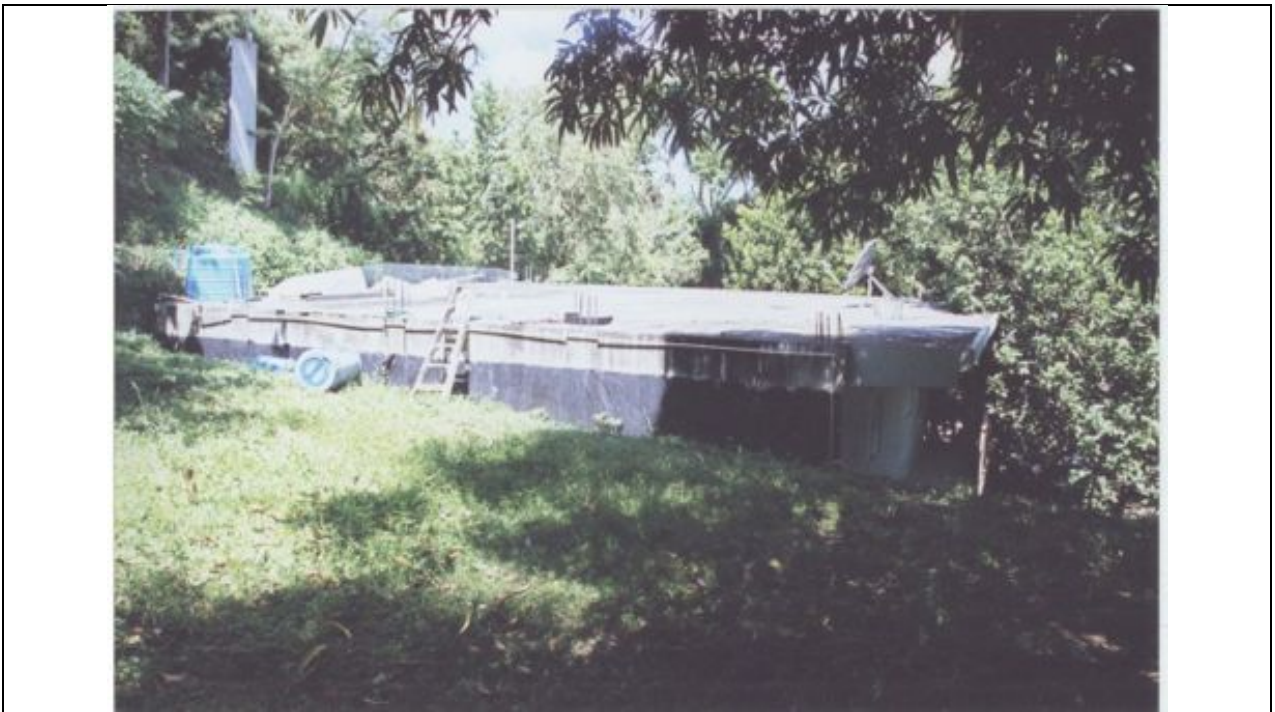
Foto 10 – Acceso al techo por la parte posterior de la residencia
