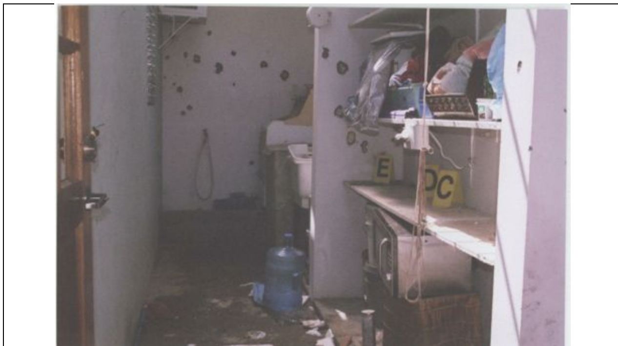
Foto 15 – Marcas de disparos en el pasillo lateral
