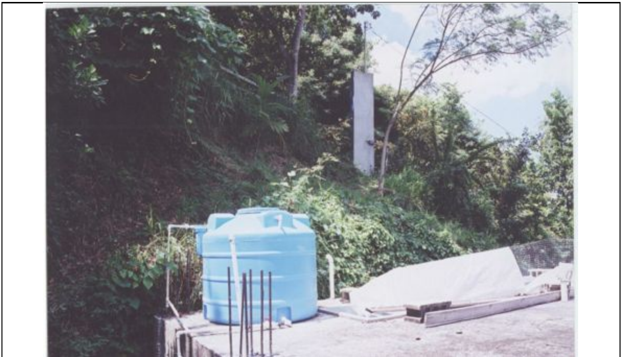
Foto 12 – Vista al muro del contador de electricidad desde el techo de la residencia
